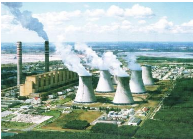
Rys. 6. Chłodnie kominowe[ www.elektrownie.com.pl ]
