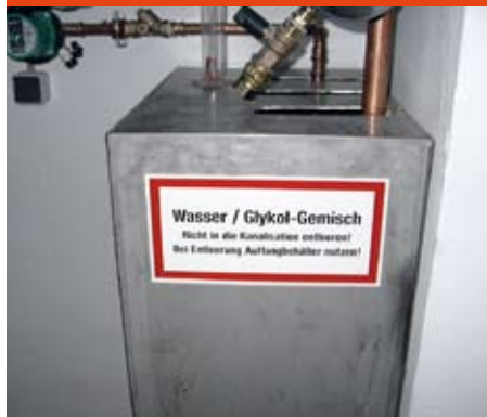
Rys. B.3.5-10 Zbiornik magazynujący
