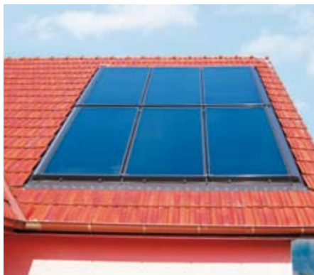
Fot. B.1.6–8 Integracja z dachem
