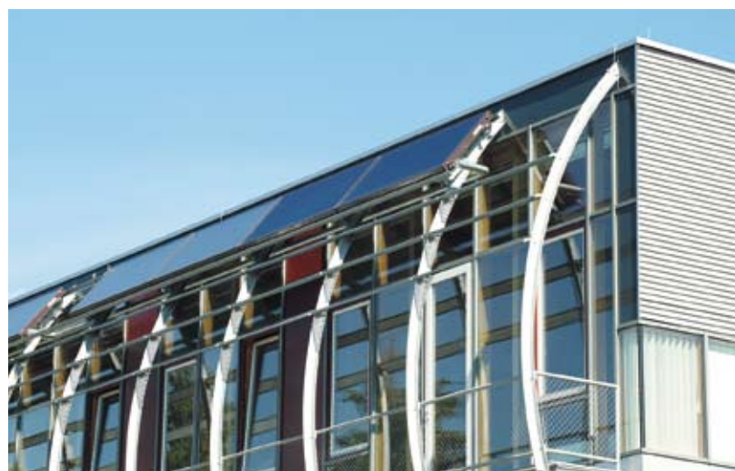
Fot. B.1.7-2 Montaż kolektorów jako roleta, baldachim
