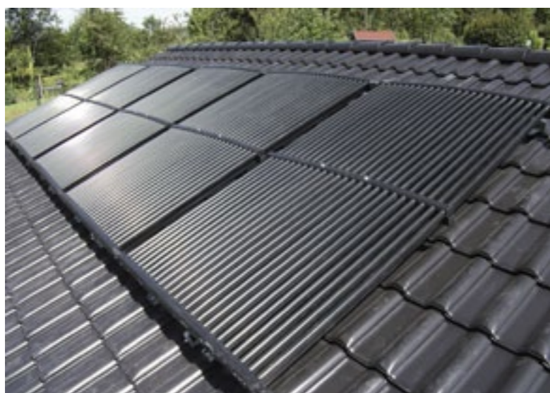
Kolektory dla zbiornika lodu
