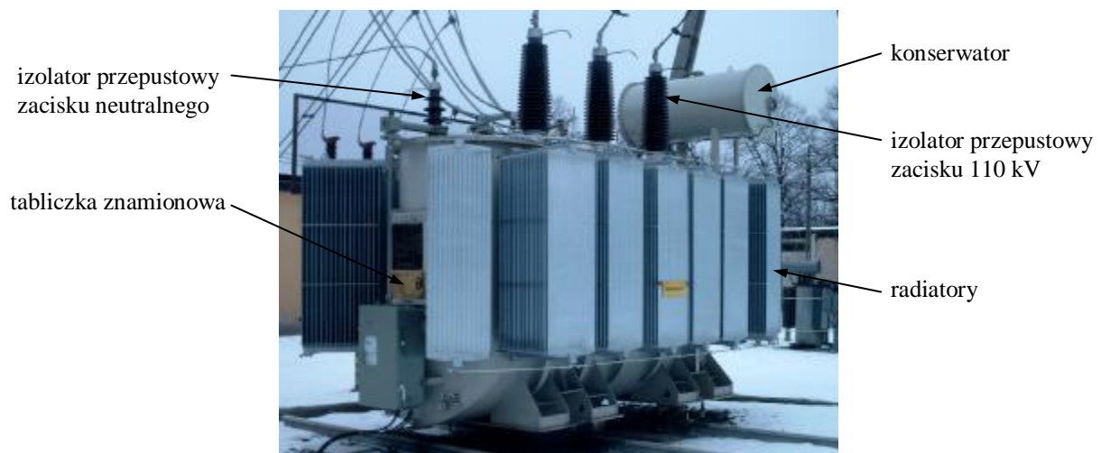
Rys. 5. Transformator 25 MVA 110/15 kV [producent: Fabryka transformatorów w Żychlinie Sp. z o. o.]
