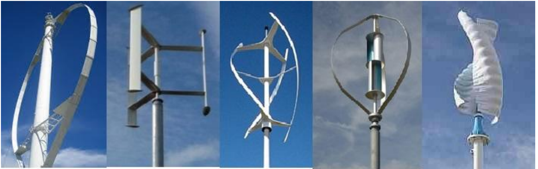
Trubiny pionowej osi obrotu, od lewej: wirnik Darrieus, Darrieus typ H, Darrieus helix, Darrieus plus Savonius, Hybryda Darrieus Savonius zwany również turbiną świderkową.
