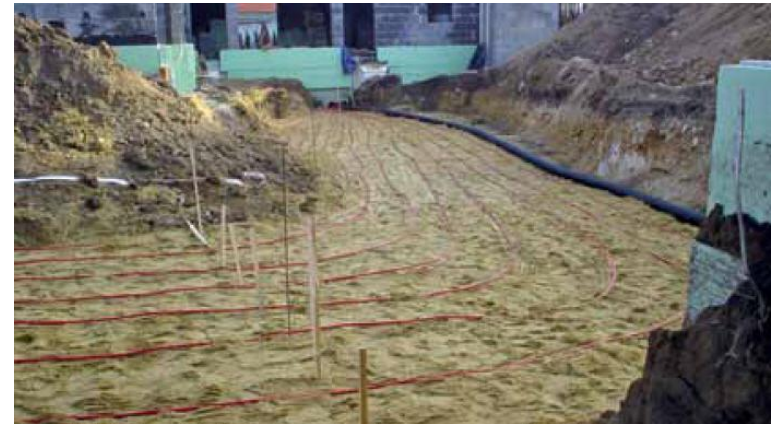
Rys. Kolektor gruntowy - poziomy.
