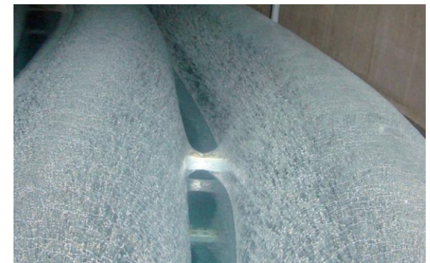
Zdj. Oblodzenie wężownic w zasobniku lodu.
