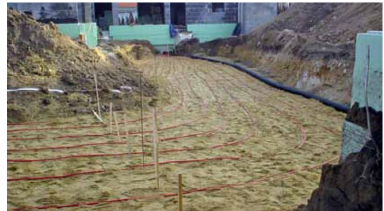
Rys. Kolektor gruntowy - poziomy.
