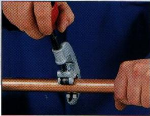
2 Przecięcie rury obcinakiem do rur
