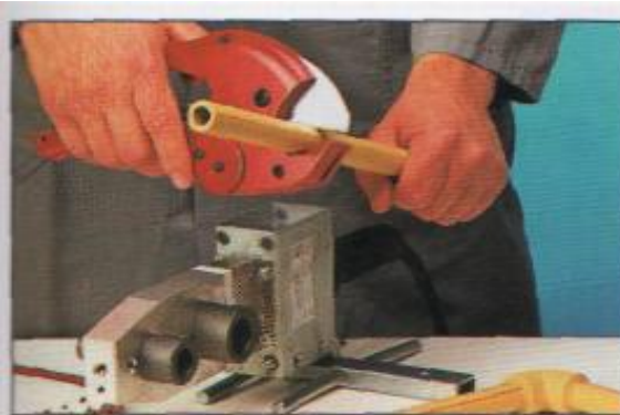
5 Przycięcie i gratowanie rury
